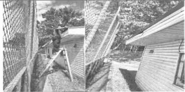
지붕 공사 후
